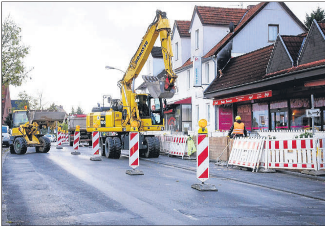
Umfangreiche Arbeiten: Bevor die Hannoversche Straße saniert wird, werden Wasserleitungen und defekte Kanäle getauscht. Hier laufen die Arbeiten gerade auf Höhe der Krebs-Apotheke. Foto: C. Hartung
